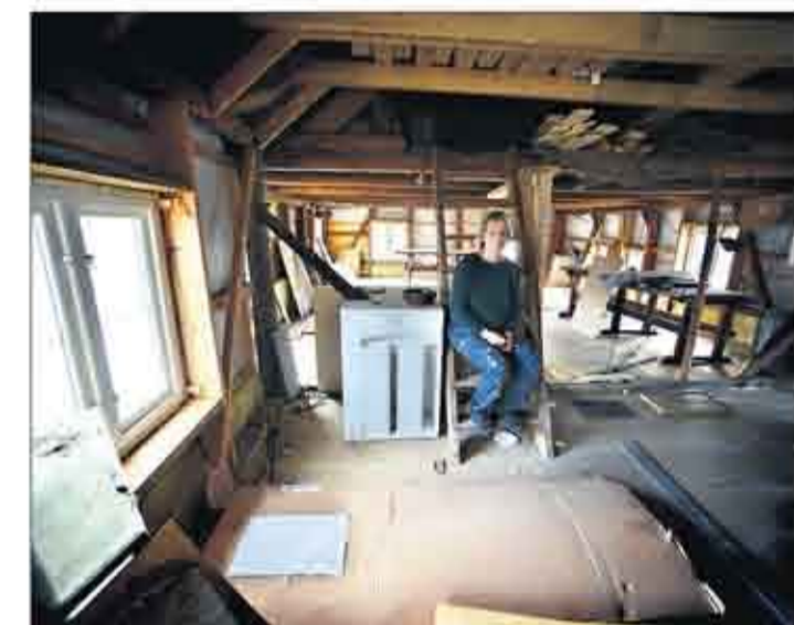
ANDRE ETASJE: Det gjenstår fortsatt mye arbeid med andre etasje. Himlingen er hevet i halve etasjen noe som muliggjør utleie. Foto: Birger Ringseth
