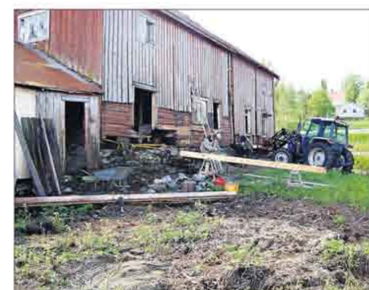
OPPRETTING: Ny grunnmur måtte mures og nye styller fra Øverbygg ble lagt til grunn i oppussingen.
