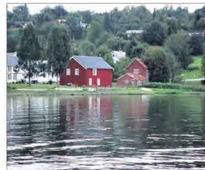
SLUKT: Løvtrær hadde nærmest slukt store deler av garveriet da dette bildet ble tatt fra Snåsavatnet på sensommeren i 2010. Foto: Privat
